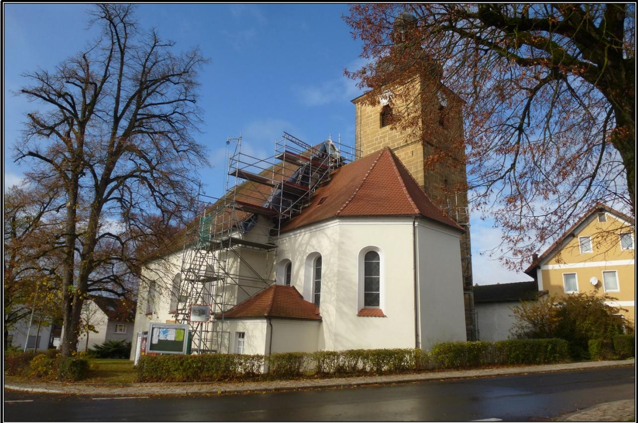
Die 1756 erbaute evangelische Martinskirche wird zurzeit im Anschlussbereich zum Giebel saniert. Undichtigkeiten im Dach und Putzschäden werden von den Firmen Kohl aus Kalchsreuth und Wurzelbacher aus Seugast behoben.
